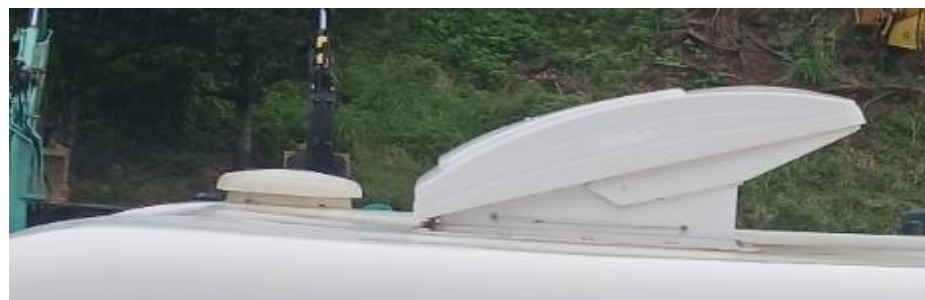
換気扇のフードが開いた状態
